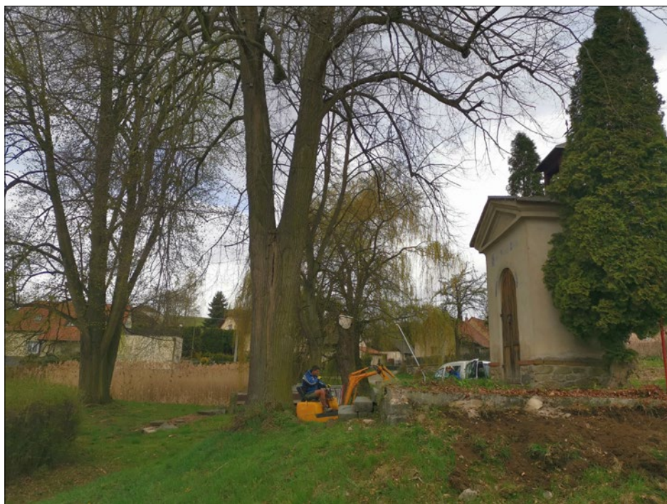
Obnova zahájena. Od úterý 14. dubna probíhají na zaječické návsi kamenické práce na kapličce. Hotové mají být během týdne. FOTO: David Kasl
