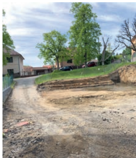
Multifunkční hřiště pod školou má hotovy zemní práce.
