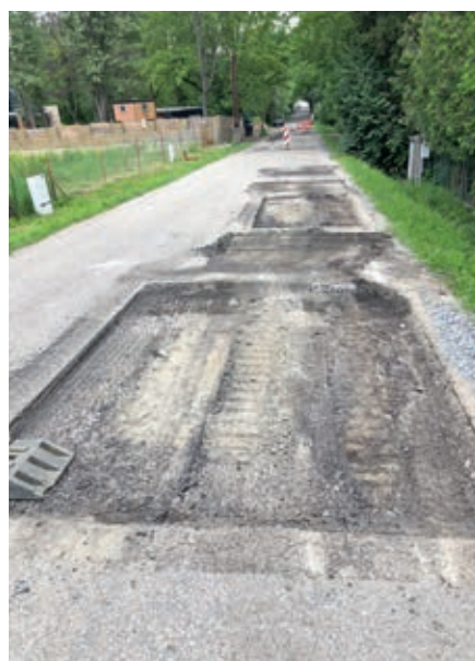
Přivaděč pitné vody ze Želivky, příprava na finální opravu povrchů ulice Nádražní
